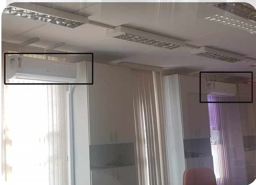
FOTO 1 : DETALHE DOS DOIS SPLITS INSTALADOS NA SECRETÁRIA DE PÓS GRADUAÇÃO
