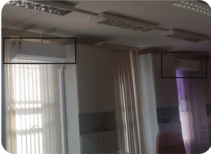
FOTO 1 : DETALHE DOS DOIS SPLITS INSTALADOS NA SECRETÁRIA DE PÓS GRADUAÇÃO
