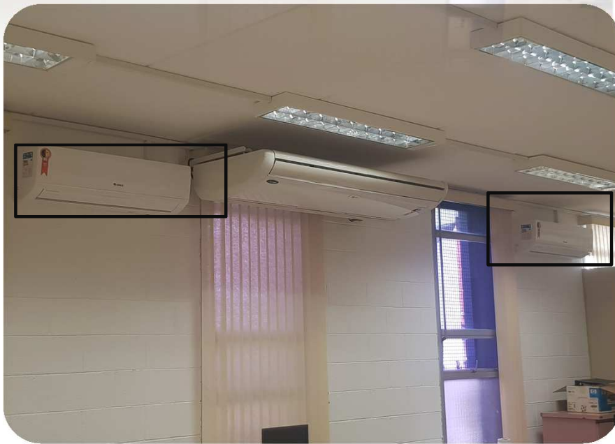
FOTO 1 : DETALHE DOS DOIS SPLITS INSTALADOS NA SECRETÁRIA UNIFICADA DA FEA.
