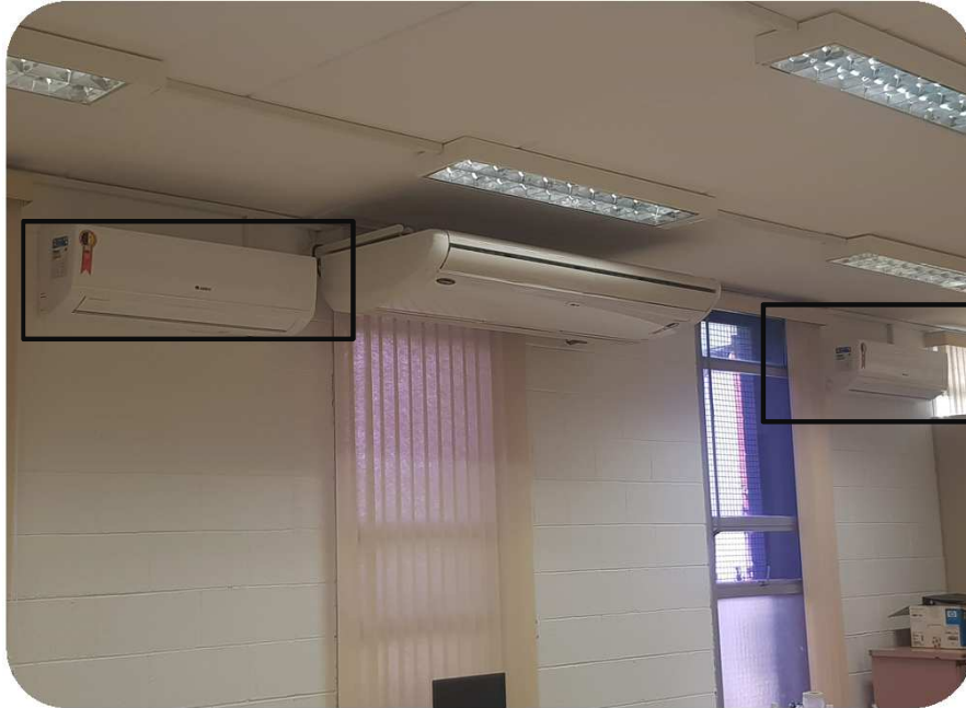
FOTO 1 : DETALHE DOS DOIS SPLITS INSTALADOS NA SECRETÁRIA UNIFICADA DA FEA.
