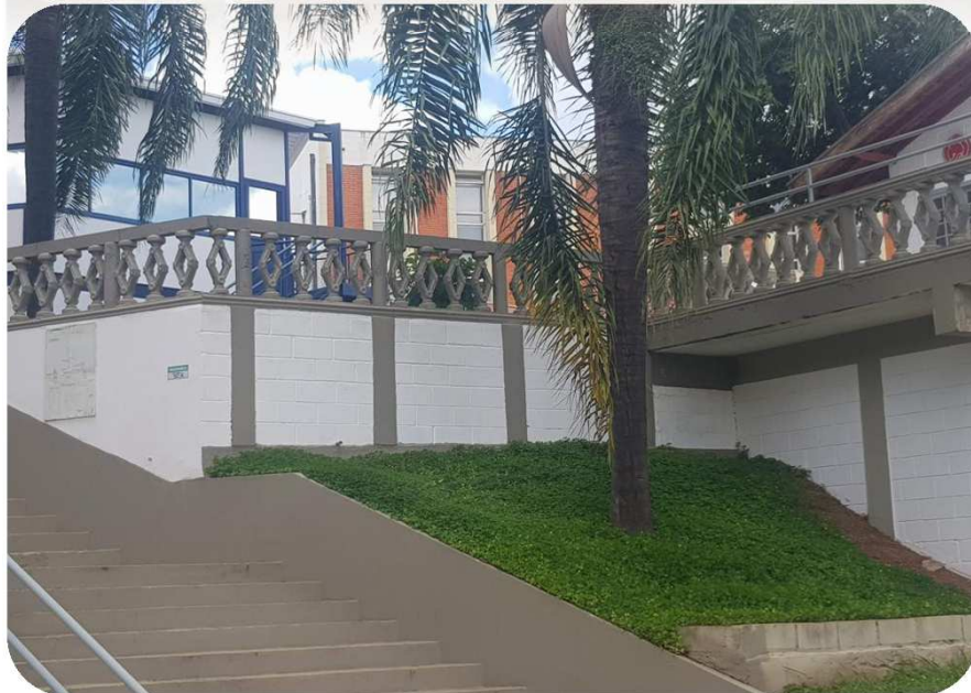
FOTO 2: DETALHE DA PINTURA REALIZADA NA ESCADARIA DA FEA.
