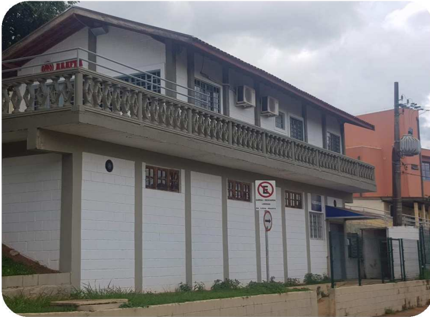
FOTO 3 : DETALHE DA PINTURA REALIZADA NO PRÉDIO DA ATLÉTICA DA FEA.
