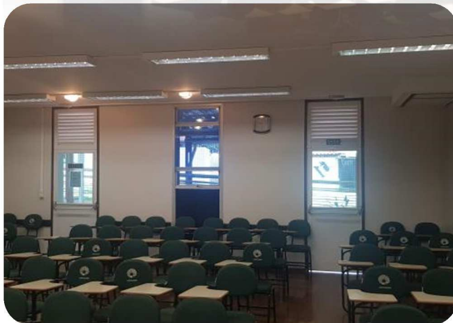
FOTO 2: DETALHE DAS PELÍCULAS REFLETIVAS INSTALADAS EM SUBSTITUIÇÃO AS PERSIANAS.
