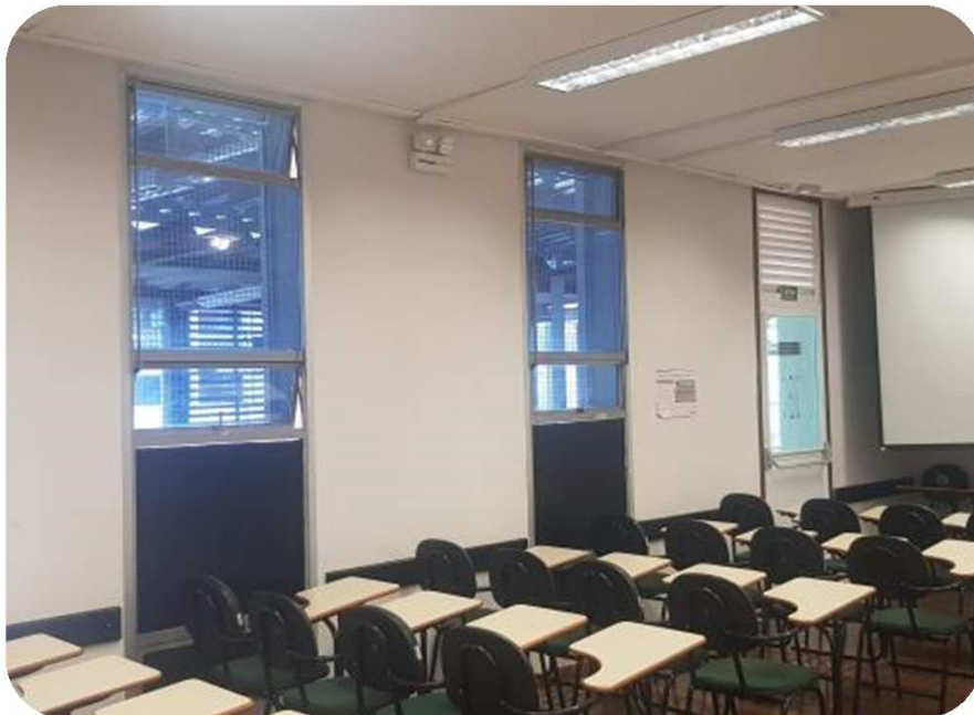
FOTO 1 : DETALHE DAS PELÍCULAS REFLETIVAS INSTALADAS EM SUBSTITUIÇÃO AS PERSIANAS.
