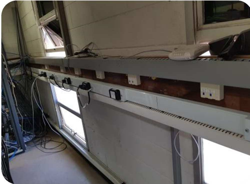
FOTO 1 : DETALHE DA INFRAESTRUTURA ELÉTRICA EXECUTADA NA SALA DE SERVIDORES DE INFORMÁTICA DA FEA - CANALETAS DE ALUMÍNIO E CIRCUITOS ELÉTRICOS INDIVIDUAIS.
