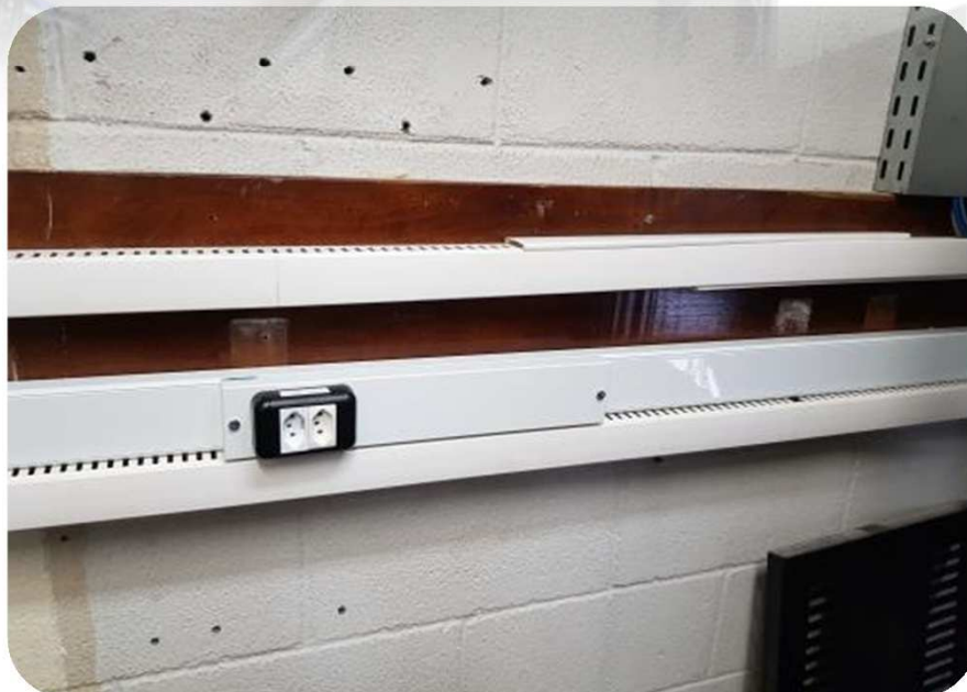
FOTO 1 : DETALHE DA INFRAESTRUTURA ELÉTRICA EXECUTADA NA SALA DE SERVIDORES DE INFORMÁTICA DA FEA - CANALETAS DE ALUMÍNIO E CIRCUITOS ELÉTRICOS INDIVIDUAIS.
