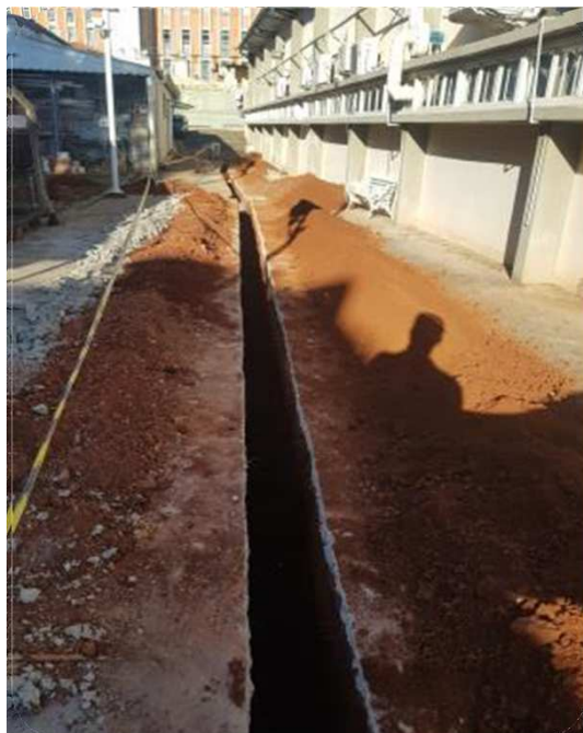
FOTO 1 E 2: FOTOS DETALHANDO A EXECUÇÃO DO CORTE DO PISO, ESCAVAÇÃO E INSTALAÇÃO DA TUBULAÇÃO DE PVC.
