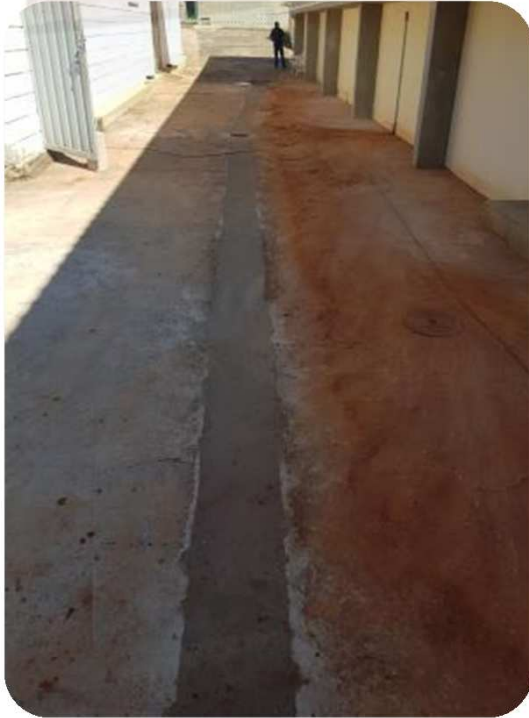
FOTO 5 E 6: DETALHE DO SERVIÇO JÁ CONCLUÍDO. REDE EXECUTADA COM CONCRETAGEM FINALIZADA.
