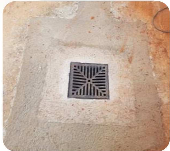
FOTO 7 E 8: DETALHE DO FINAL DO TRECHO DAS REDES EXECUTADAS. A NOVA REDE DE DRENAGEM ESCOARÁ ÁGUA PARA A BOCA DE LOBO EXISTENTE NA MECÂNICA, CONFORME PROJETO APROVADO JUNTO A DSIS/PREFEITURA.
