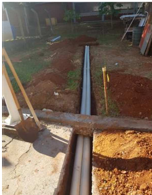
FOTO 1 E 2: FOTOS DETALHANDO A EXECUÇÃO DO CORTE DO PISO, ESCAVAÇÃO E INSTALAÇÃO DA TUBULAÇÃO DE PVC.
