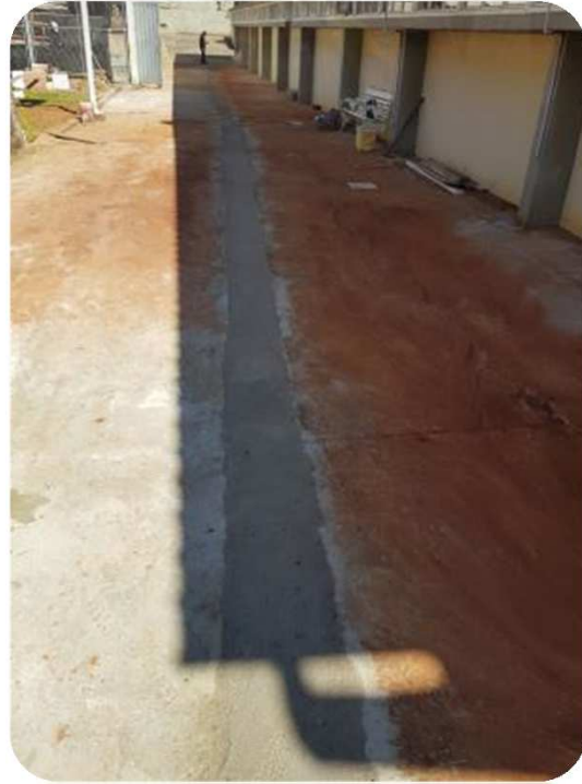
FOTO 5 E 6: DETALHE DO SERVIÇO JÁ CONCLUÍDO. REDE EXECUTADA COM CONCRETAGEM FINALIZADA.
