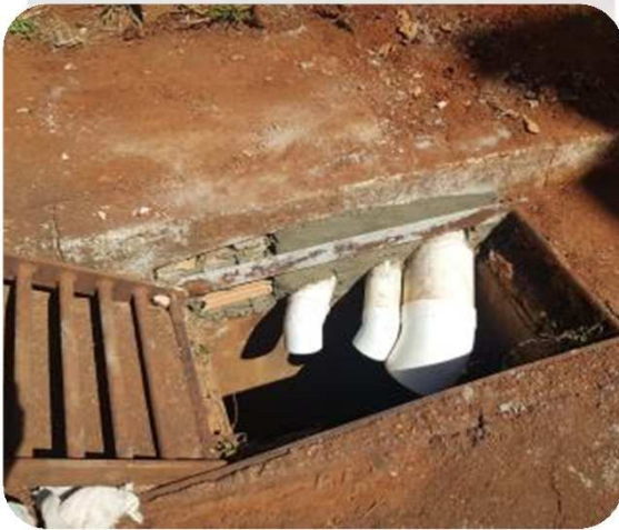
FOTO 7 E 8: DETALHE DO FINAL DO TRECHO DAS REDES EXECUTADAS. A NOVA REDE DE DRENAGEM ESCOARÁ ÁGUA PARA A BOCA DE LOBO EXISTENTE NA MECÂNICA, CONFORME PROJETO APROVADO JUNTO A DSIS/PREFEITURA.
