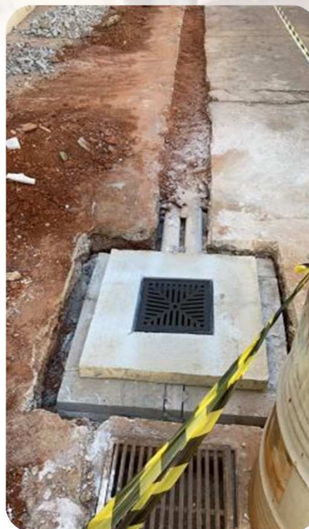
FOTO 3 E 4: FOTOS DAS CAIXAS DE ALVENARIA SENDO EXECUTADAS.
