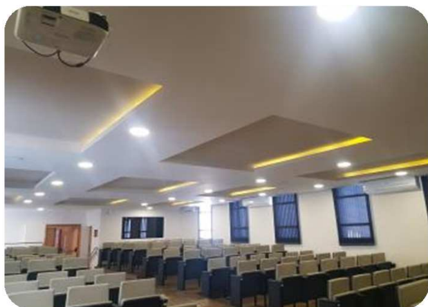
FOTO 1 E 2: DETALHE DO FORRO DE GESSO DO SALÃO NOBRE APÓS EXECUÇÃO DA PINTURA.
